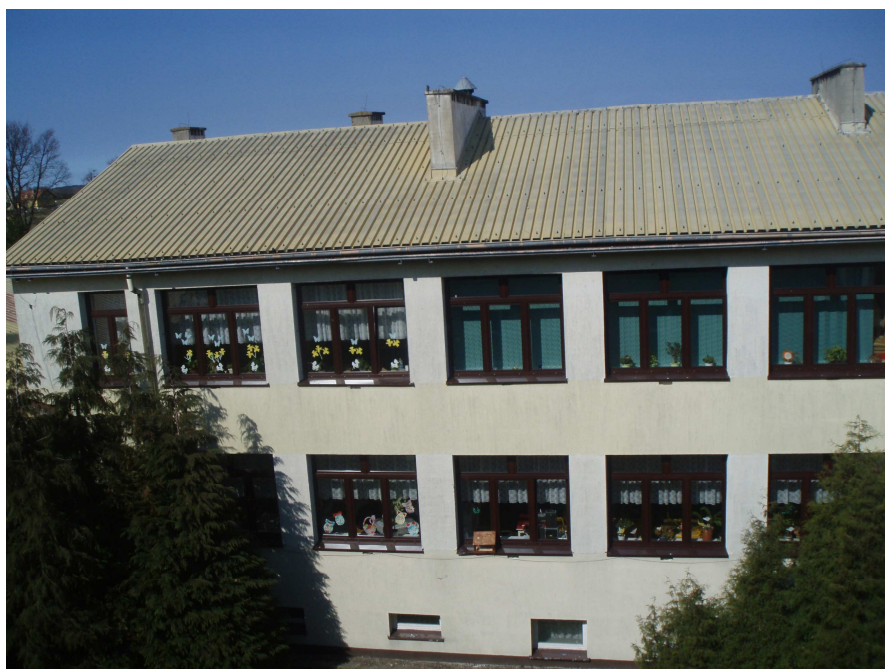
Rys. 3.1. Widok fragmentu budynku szkolnego – BUDYNEK „A”.
